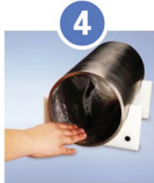
Schritt 4: Glatte Oberfläche der wasserlöslichen Folie auf den Kleber im Rohr drücken.
