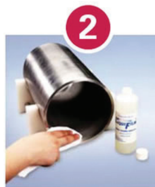
Schritt 2: Wasserlöslichen Folienkleber auf das Rohr auftragen.
