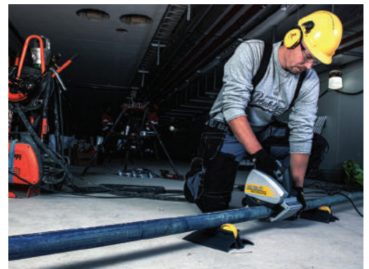
Rohre trennen und anfasen
