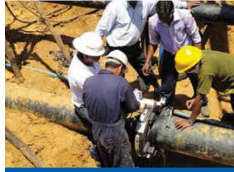
Trennung dickwandiger Rohre
